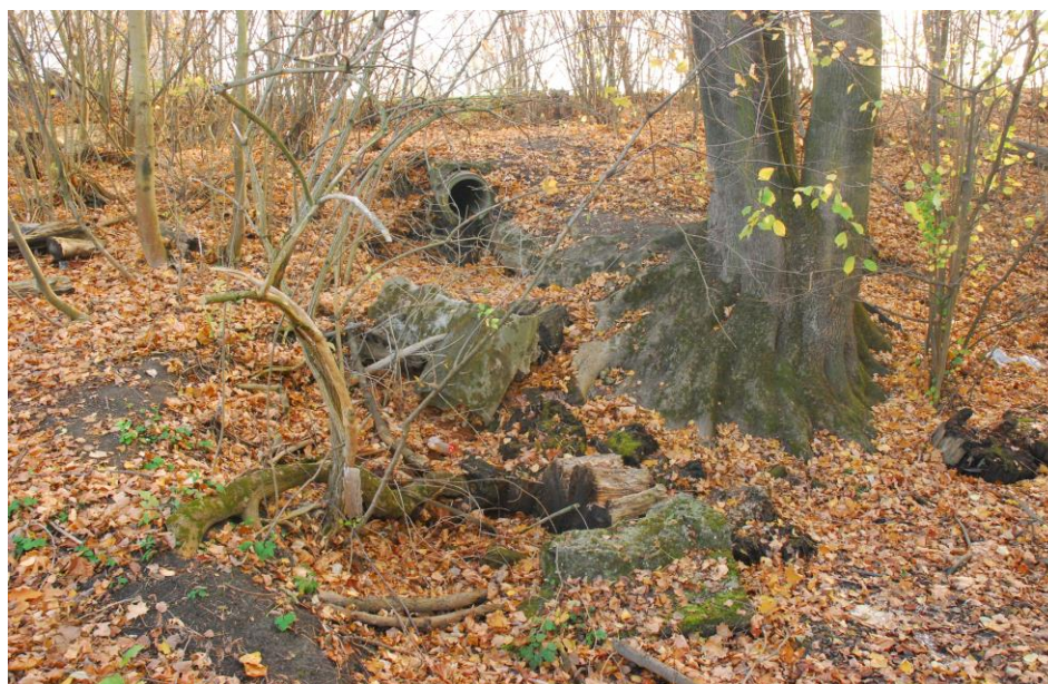
Pohled na zničené vyústění vypouštěcího potrubí do Mlýnského potoka
